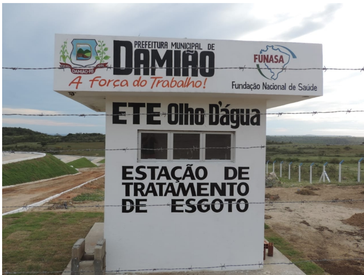
Figura 12 – Estação de Tratamento de Esgoto
