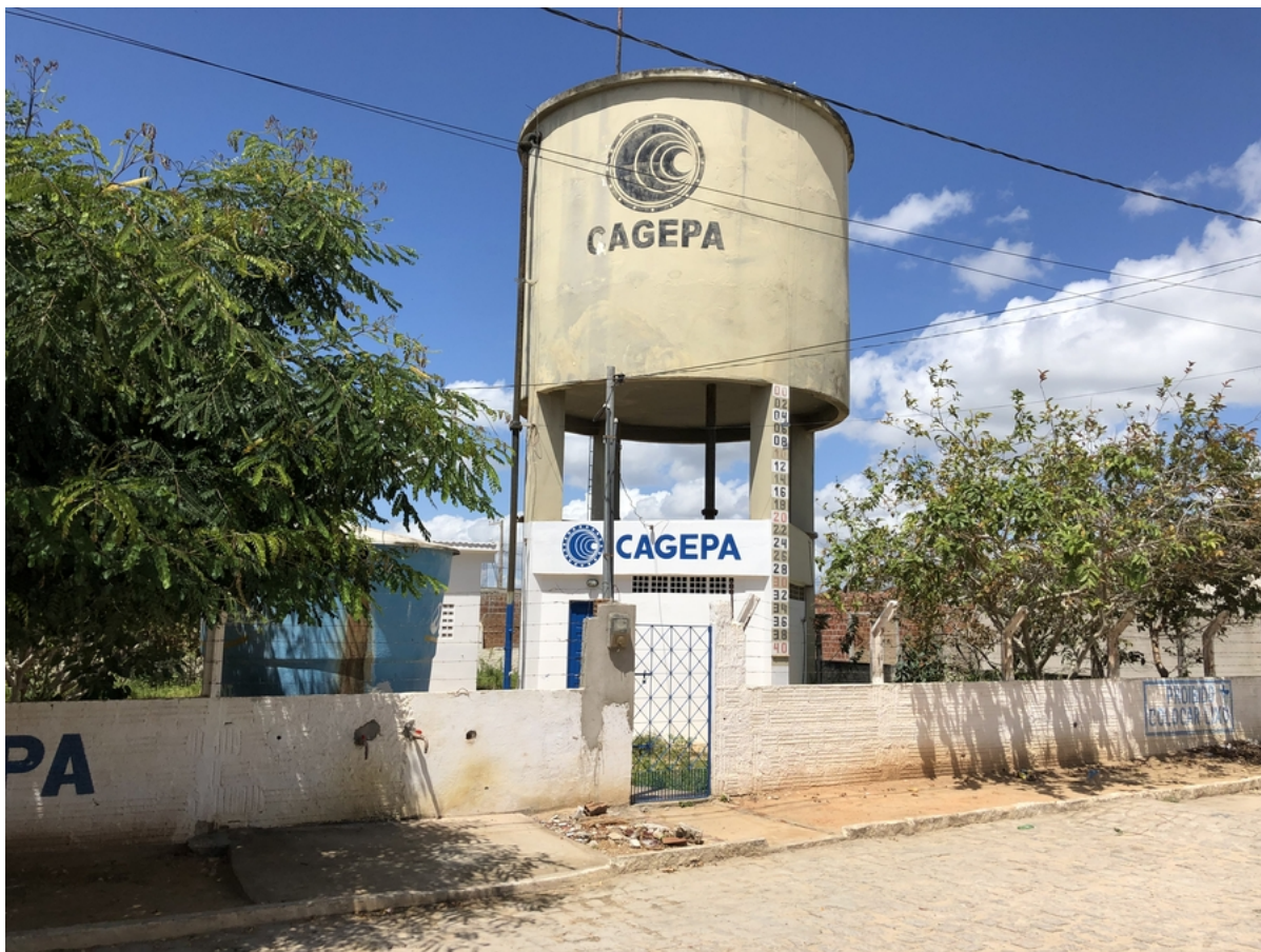
Figura 11 – Caixa de distribuição de Água localizada no município de Damião
